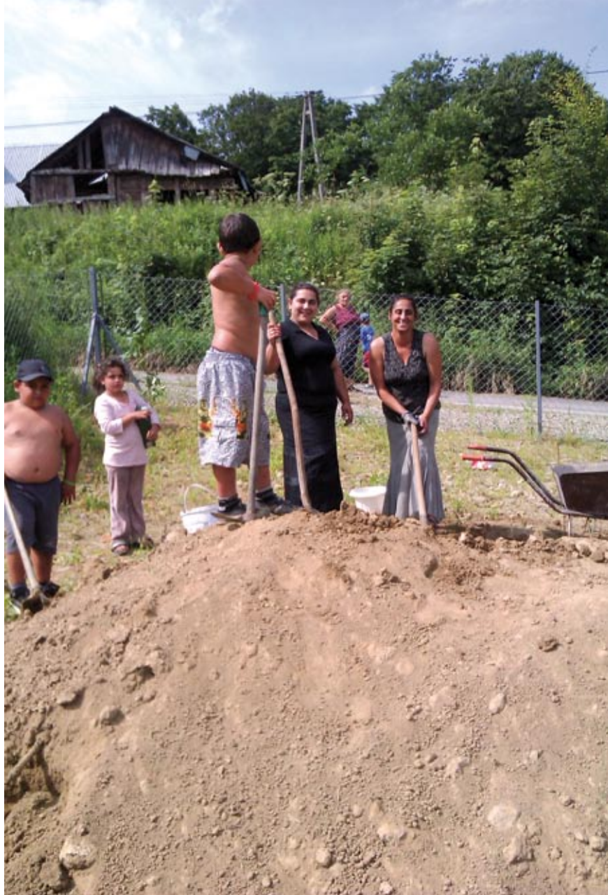
Początki świetlicy, prace porządkowe.
