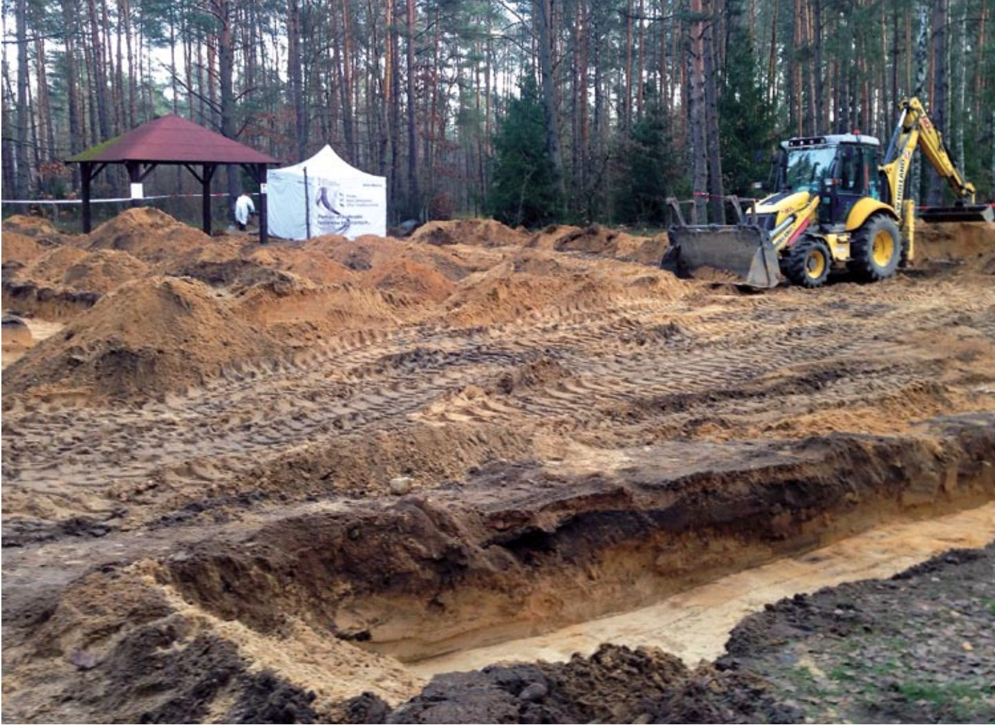
(fot. „a”) Prace ziemne na terenie parkingu i w strefie jego obwodu podjęto na podstawie wskazań georadaru ujawniającego naruszenie warstw osadu, mogących być wskaźnikiem jam grobowych. Fot. Gerard Gierliński
