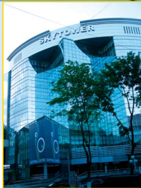
Nowoczesny budynek Sky Tower w centrum Kiszyniowa. fot. wikipedia
